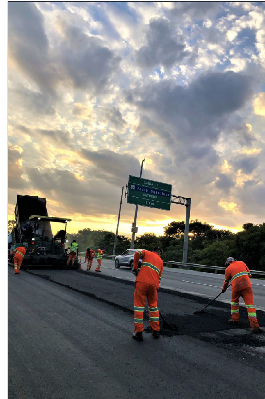
Obras no Consórcio SP-070
