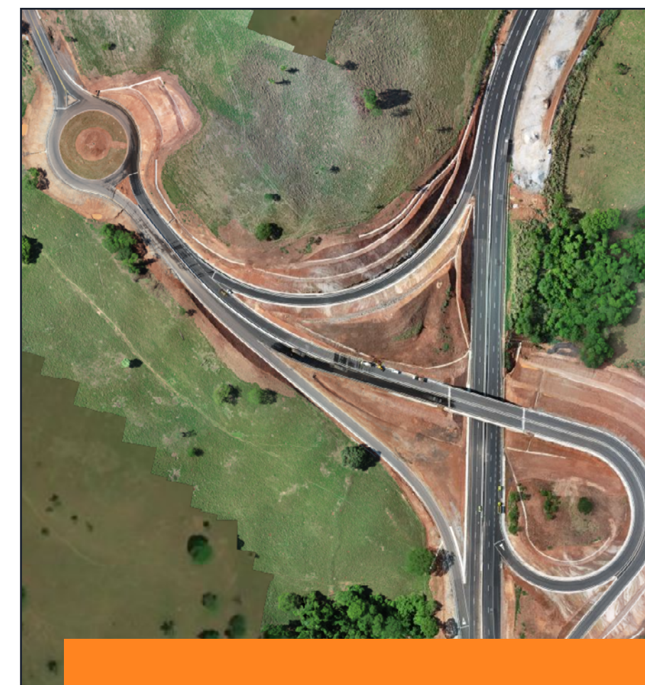
Imagem da obra BR-050, gerada por drone para topografia e levantamento de campo, através de aerofotogrametria
